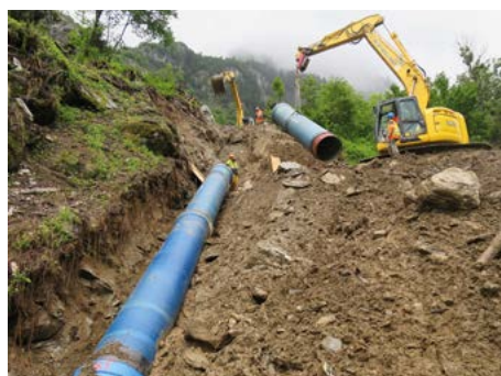
Montage der Gussrohre DN 1000 in der Steilstufe unter erschwerten Bedingungen
