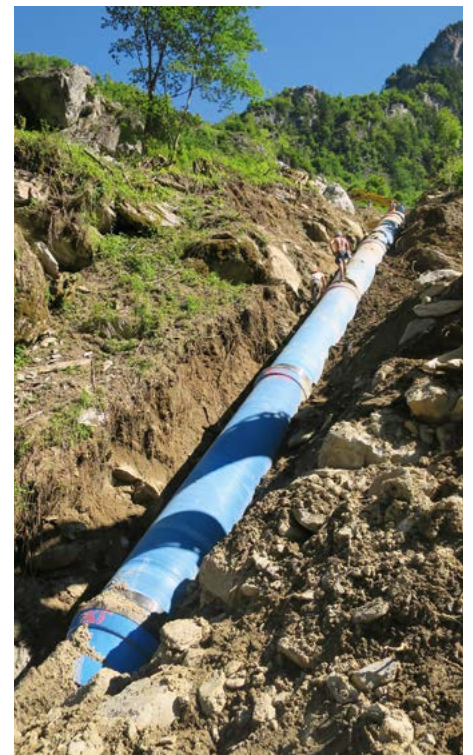
Anderntags konnte die Kraftwerksleitung bereits wieder verfüllt werden.
