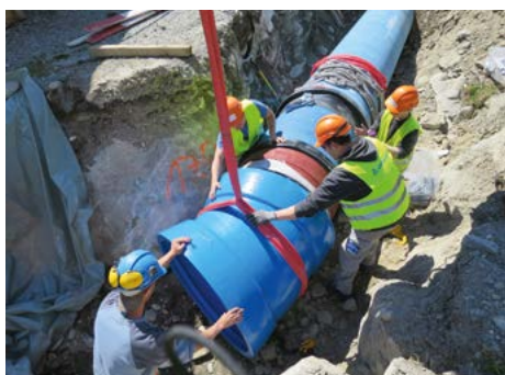
Montage eines der total 40 Formstücke (Montagezeit ca. 15 min)
