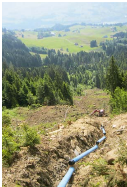
Bereit zur Montage von oben nach unten
