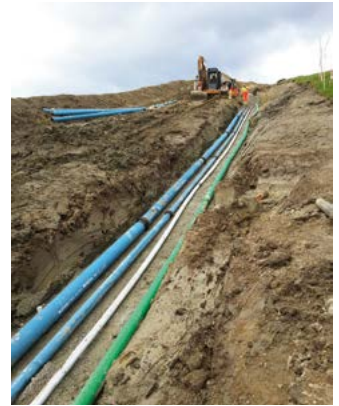
Turbinen- und Versorgungsleitung Duktus BLS/FZM im selben Graben
