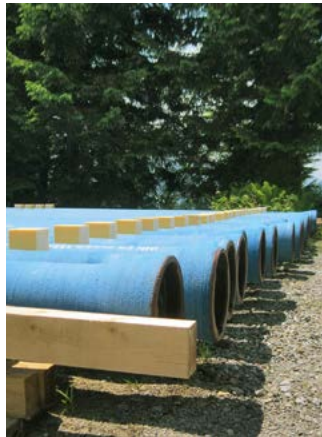
Rohrlager bereit zur Verlegung mittels Helikopter
