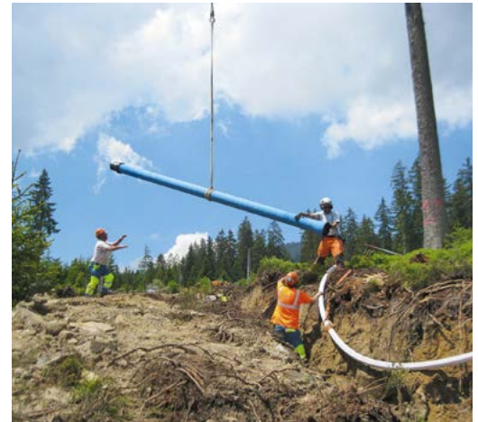
Einflug der Gussrohre DN 200 in steilem Gelände
