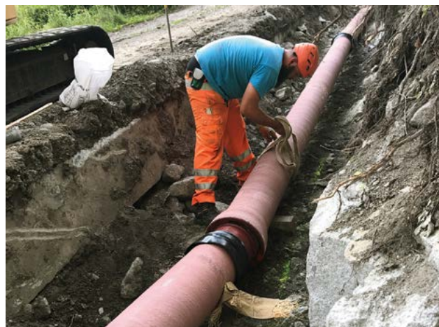
Dank der Auslenkung der einzelnen Muffen bis 3° konnten diverse Bogen eingespart werden.
