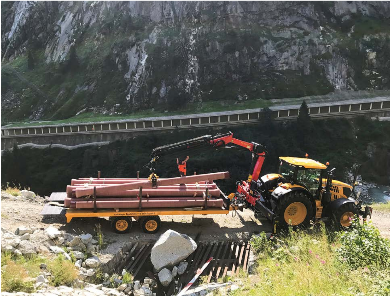
Vom Lagerplatz in Göschenen wurden die Rohre mit einem Traktor und Anhänger zum Zwischendepot geführt. Und von dort mit einem Spezialfahrzeug zum Rohrgraben gebracht.
