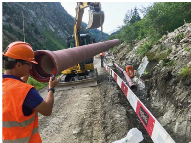
Verlegung der Gussrohre DN 250 BLS/FZM/TZ auf der Galerie der Schöllenenstrasse
