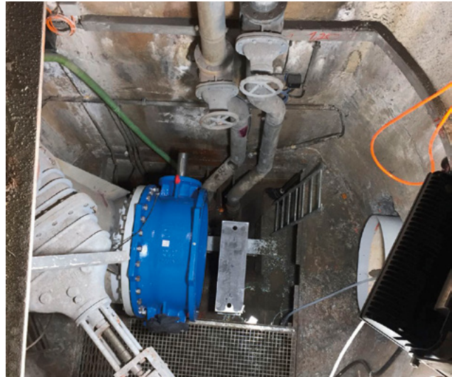
Montage der ersten Klappe (ohne Fallgewichts Antrieb) Montage de la première vanne (sans contrepoids)
