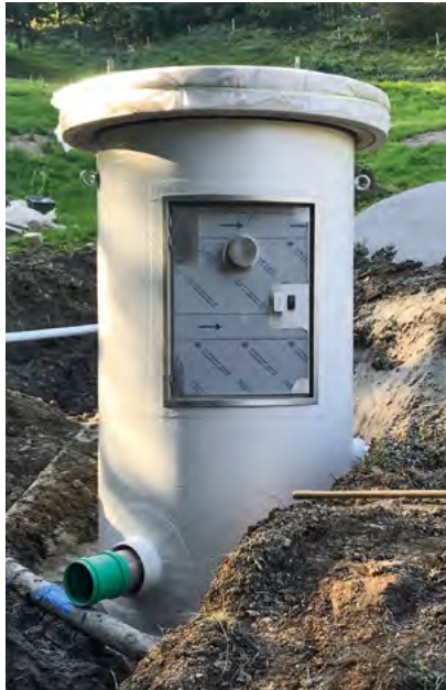
Platzierung einer neuen «Aquaniro»-Brunnenstube DN 1800 im Quellgebiet «Wiesle»
