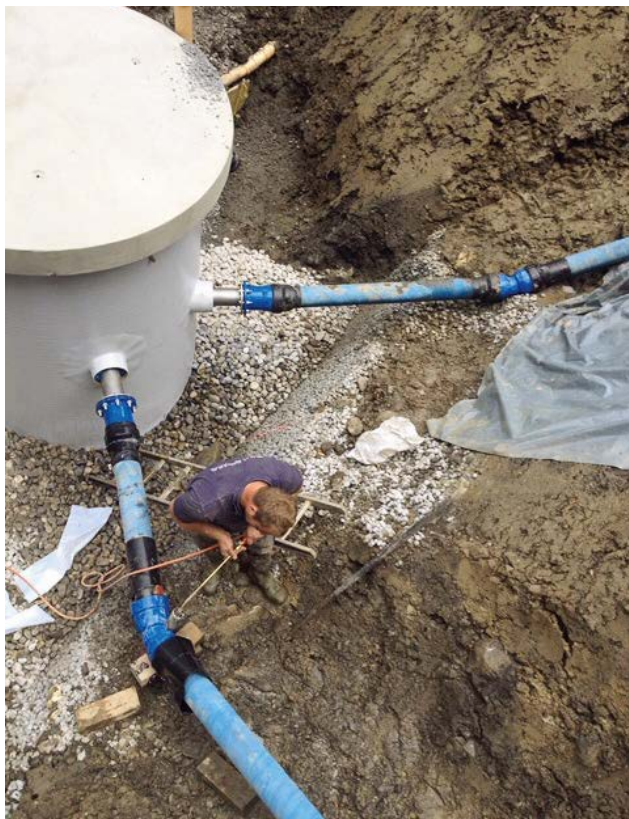
Quellzuläufe mit FZM-Gussrohren von Duktus/Hagenbucher
