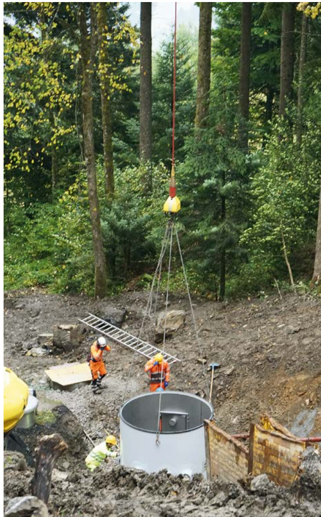
Versetzen auf bauseitiges Bankett
