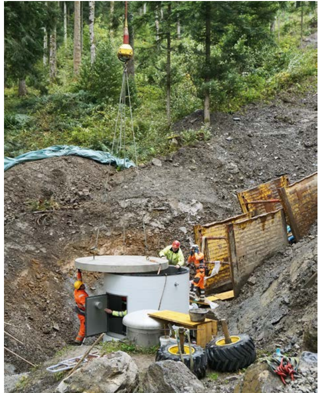
Aufsetzen des Deckels mit Hilfe des Helikopters
