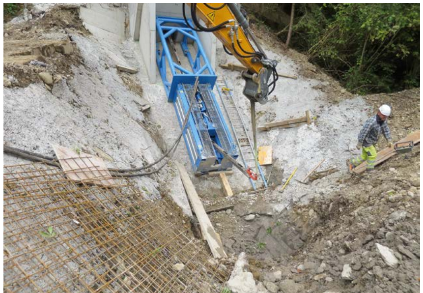
Aufwändiger Tiefbau für das Anstellen der 190-Tonnen-Maschine von TPS
