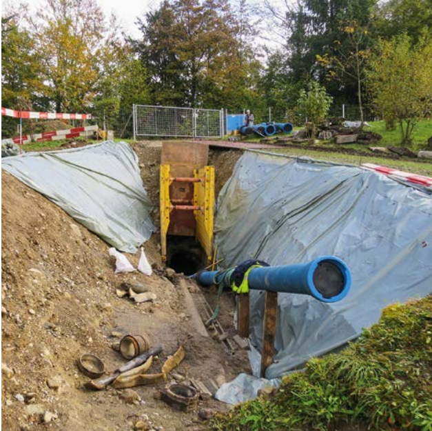
Konventioneller Rohreinzug durch altes Eternitrohr
