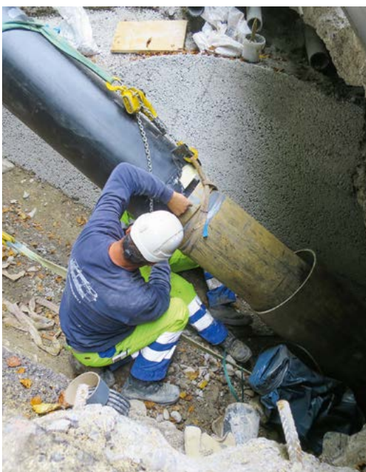
Montage Parallelrohr für den Einzug DN 300 mm
