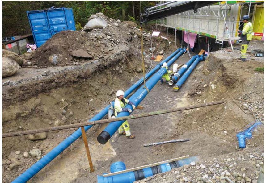
Anschluss Pumpwerk, Leitungsbau durch TPS
