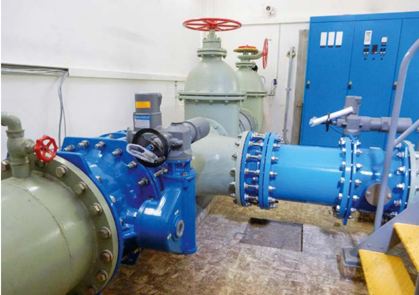
Fertiger Einbau der neuen Formteile und Armaturen DN 500 und DN 400
