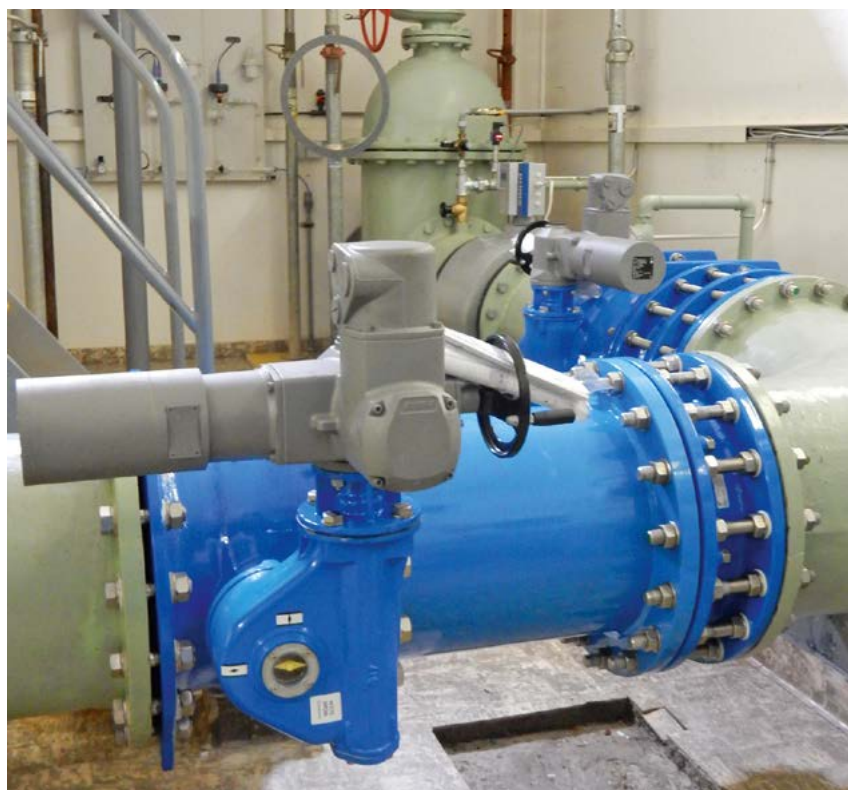
Klappe mit E-Antrieb und Stellungsanzeiger
