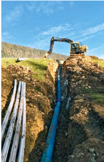
Verlegung direkt in den Graben, die Auffüllung erfolgt mit dem Aushubmaterial, ... Pose directement dans les fouilles, remplissage avec les matériaux d'excavation...
