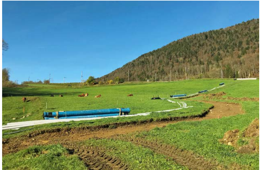
Problemlose Verlegearbeiten bei Sonnenschein in der grünen Natur von Saint-Imier...
