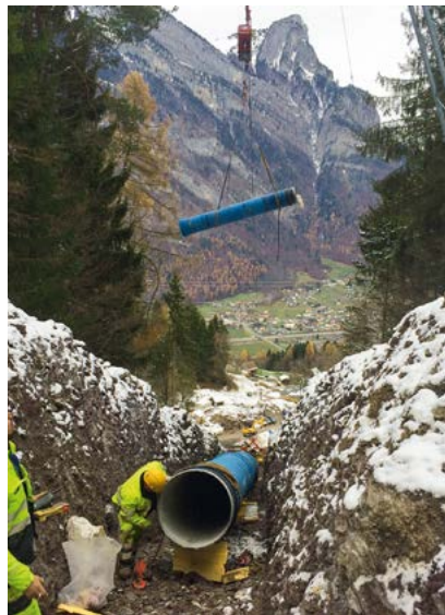
Verlegung mit Hilfe von Seilbahn...
