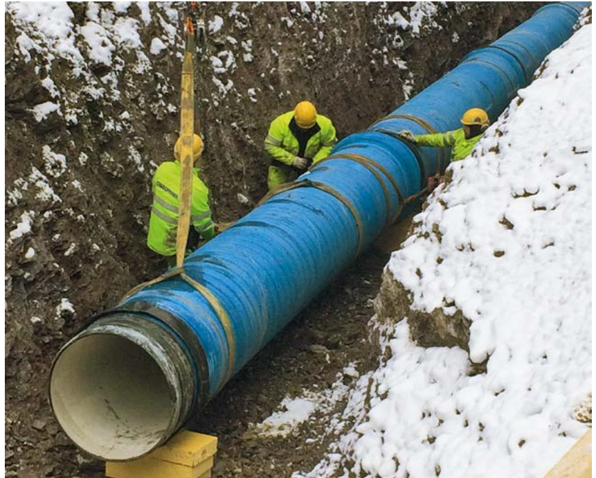
Zügige Verlegung trotz Schnee und Kälte
