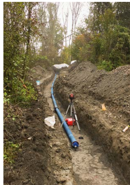
Dank der FZM-Beschichtung kann der Aushub als Rohrumhüllung wieder verwendet werden.
