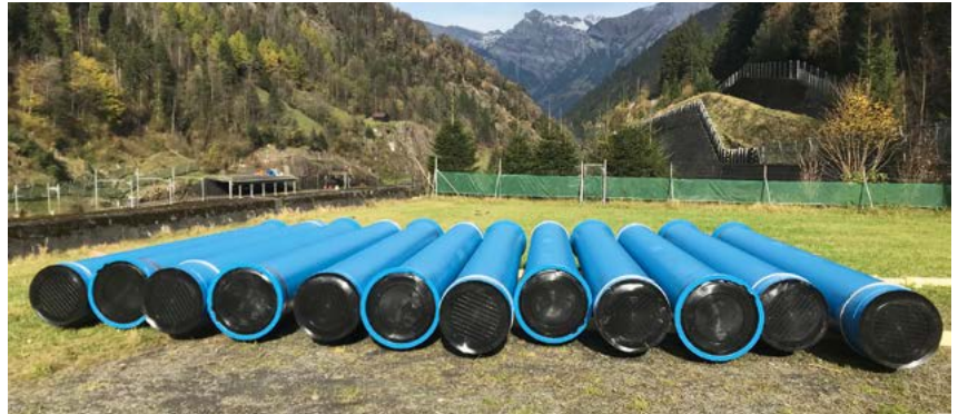
Rohrlager auf dem Galeriedach der Gotthardautobahn
