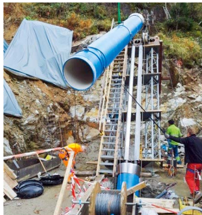
Einbringen der Gussrohre DN 600 über die Montagerampe
